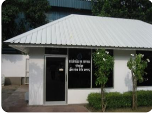
ป.ต.ท. สถานีน้ำมัน (ไทยแลนด์), ตุลาคม 2010: 46% ประหยัดค่าพลังงานการทำความเย็นปรับอากาศ
