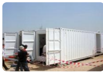
สำนักงานคอนเทนเนอร์ (ซาอุดีอาหรับ), 2009.
