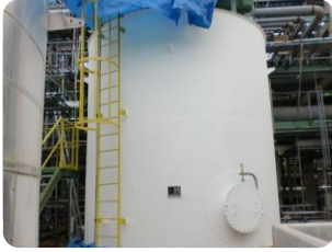
โตโย โทโย (ไทยแลนด์), กันยายน, 2010: ถังบรรจุสารเคมีทนความร้อนป้องกันความร้อนกระจายออก
