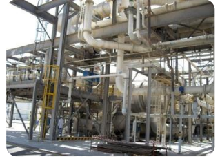
Dubai อลูมิเนียม (อเมิโตะ), 2009: อุณหภูมิที่ลดลง 13 องศาเซลเซียส กว่าการใช้ เซรามิกโคดท์
